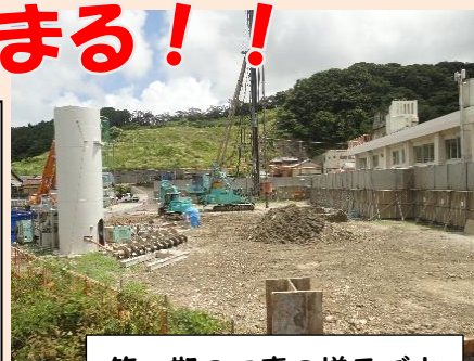
第一期の工事の様子です
